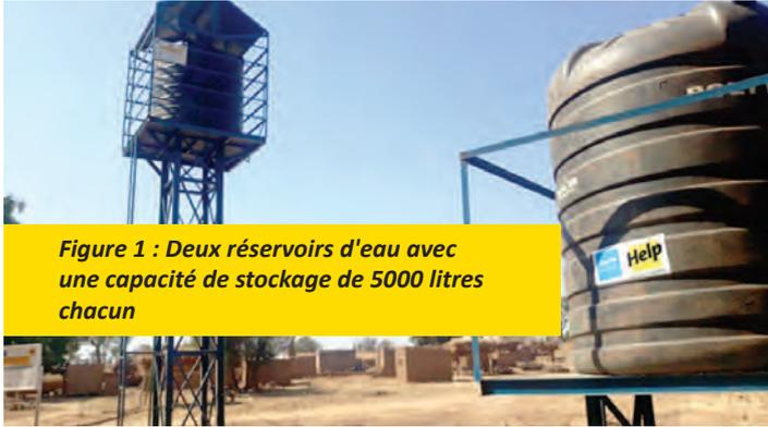
Figure 1 : Deux réservoirs d'eau avec une capacité de stockage de 5000 litres chacun
